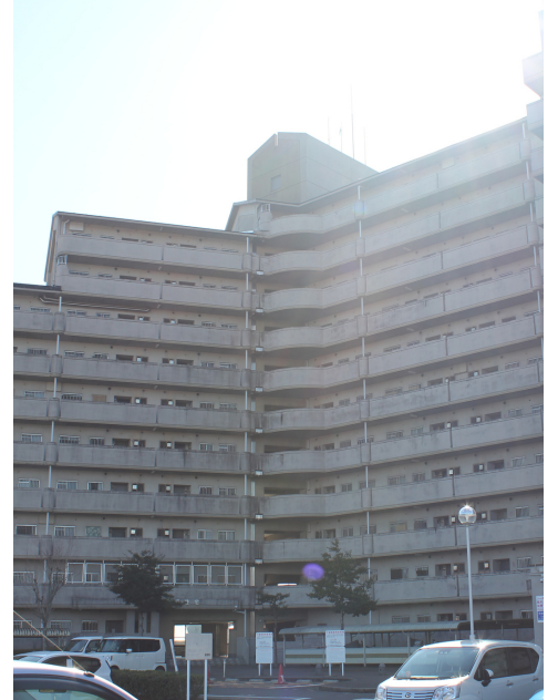
県営三好丘旭住宅
